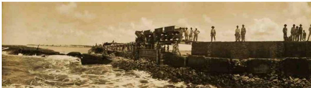
Figura 13: Fotografia da construção do Dique do Nogueira.
