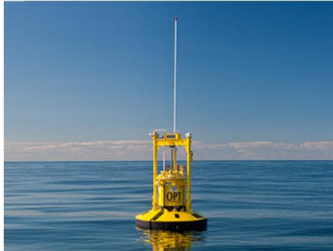
Figura 5 - Absorvedor de energia de ondas do tipo pontual. Fonte: Powerbuoy.
