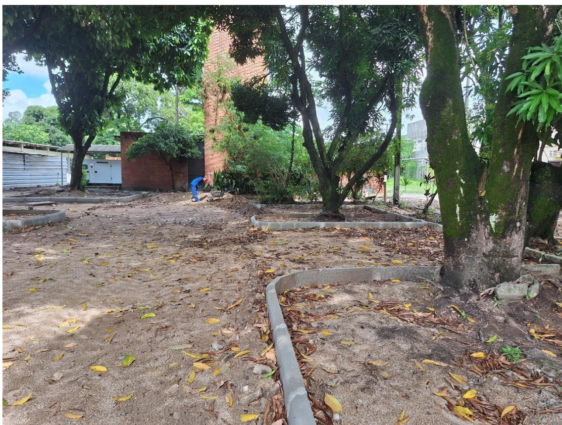
Demolição de piso existente em bloco de pedra tipo paralelepípedo
