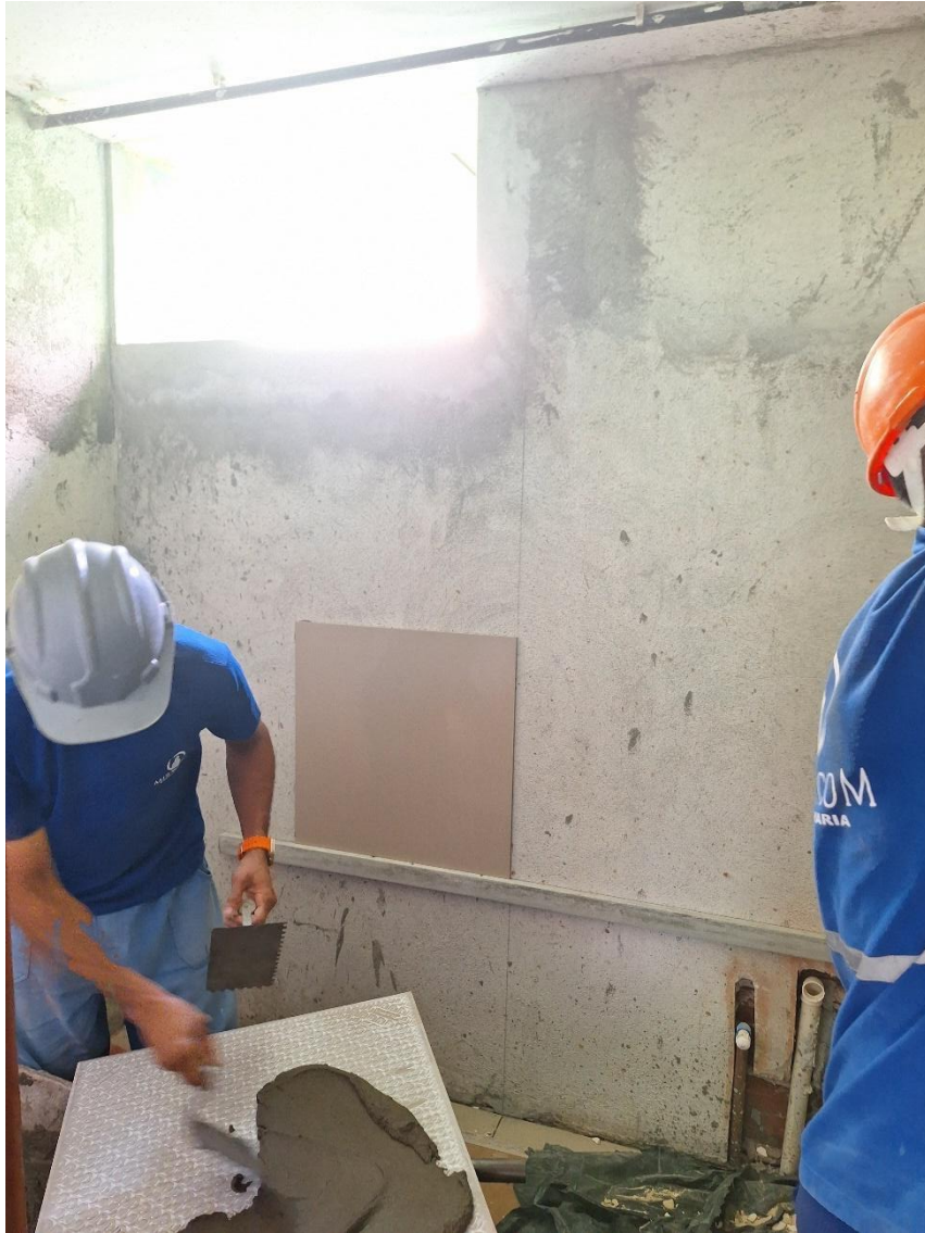
Aplicação de revestimento cerâmico nos wcs de acessibilidade
