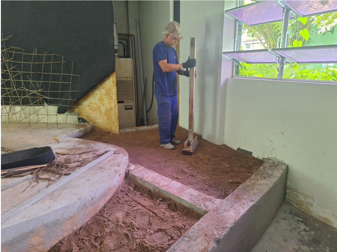
Compactação do solo do auditório no palco
