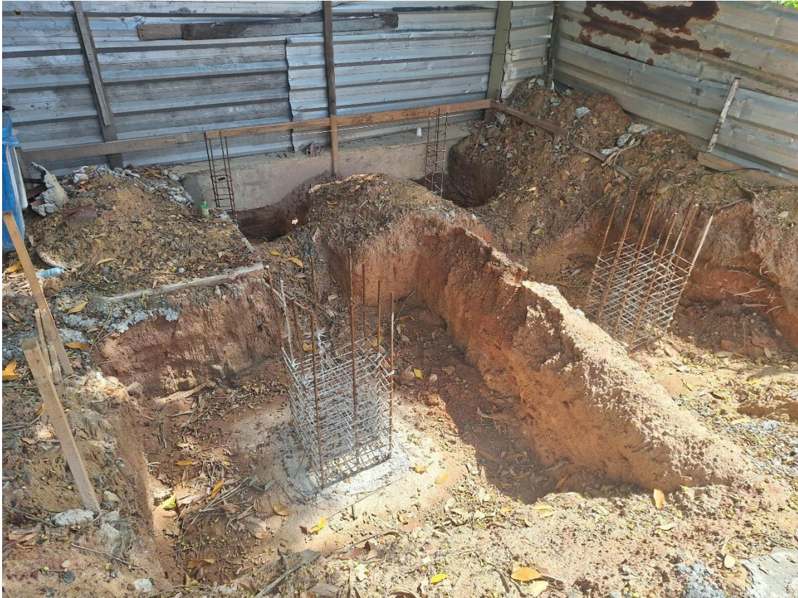
Concretagem de sapatas da passarela do auditório
