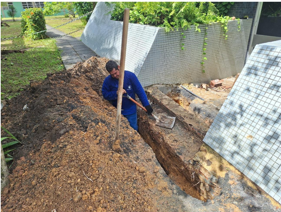
Escavação manual para bloco de coroamento ou sapata
