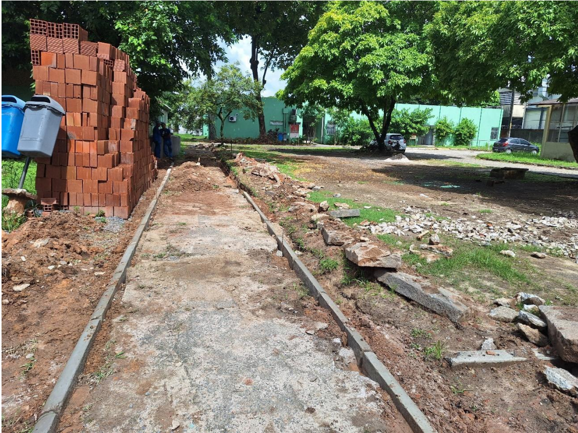
Assentamento de guia(meio-fio) no trecho da
