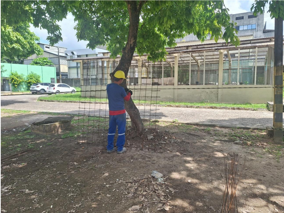
Fabricação de vigas, sapatas
