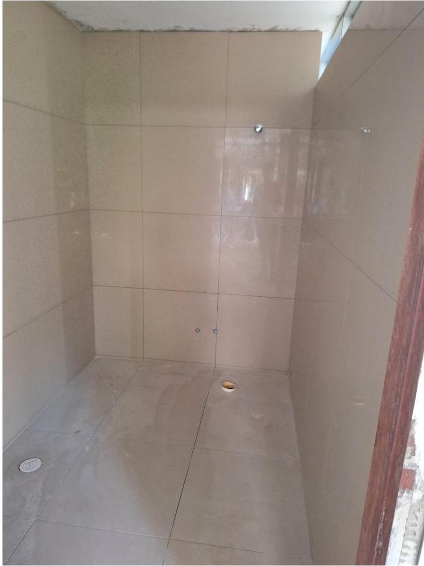
Aplicação de revestimento cerâmico finalizado
